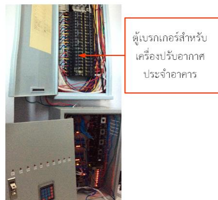
ภาพที่ 9 การติดตั้งตู้ควบคุมระบบเข้ากับตู้เบรกเกอร์
