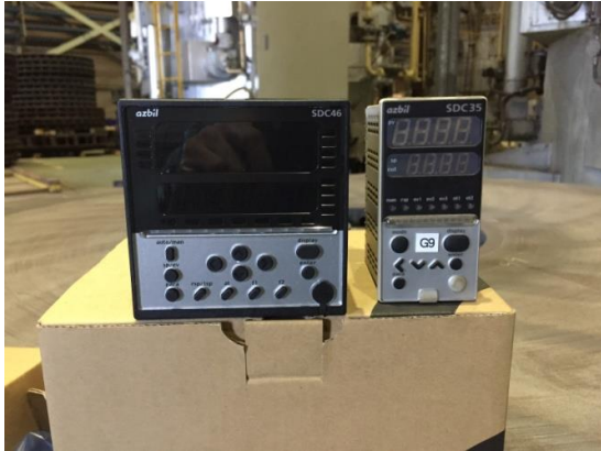
ภาพที่ 4 แสดงการเปลี่ยนชุดควบคุมอัตราการไหลของวาล์ว เชื้อเพลิงจากชุดควบคุมจากโมเดลเดิมเป็นรุ่นใหม่
