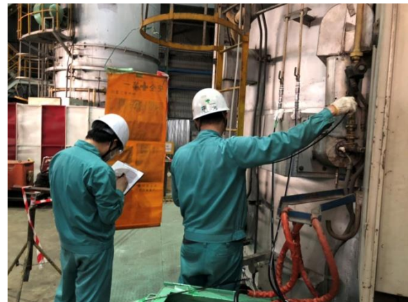
ภาพที่ 3 แสดงการจัดเก็บข้อมูลแรงดันและอัตราการไหล ของลมและเชื้อเพลิงและค่าออกซิเจนจากการเผาไหม้
