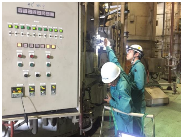
ภาพที่ 5 แสดงการเปลี่ยนชุดควบคุมอัตราการไหลของวาล์ว เชื้อเพลิงจากชุดควบคุมจากโมเดลเดิมเป็นรุ่นใหม่
