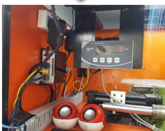
ติดตั้งอุปกรณ์ไฟฟ้า เช่น PLC, sensors, DC motor เป็นต้น
