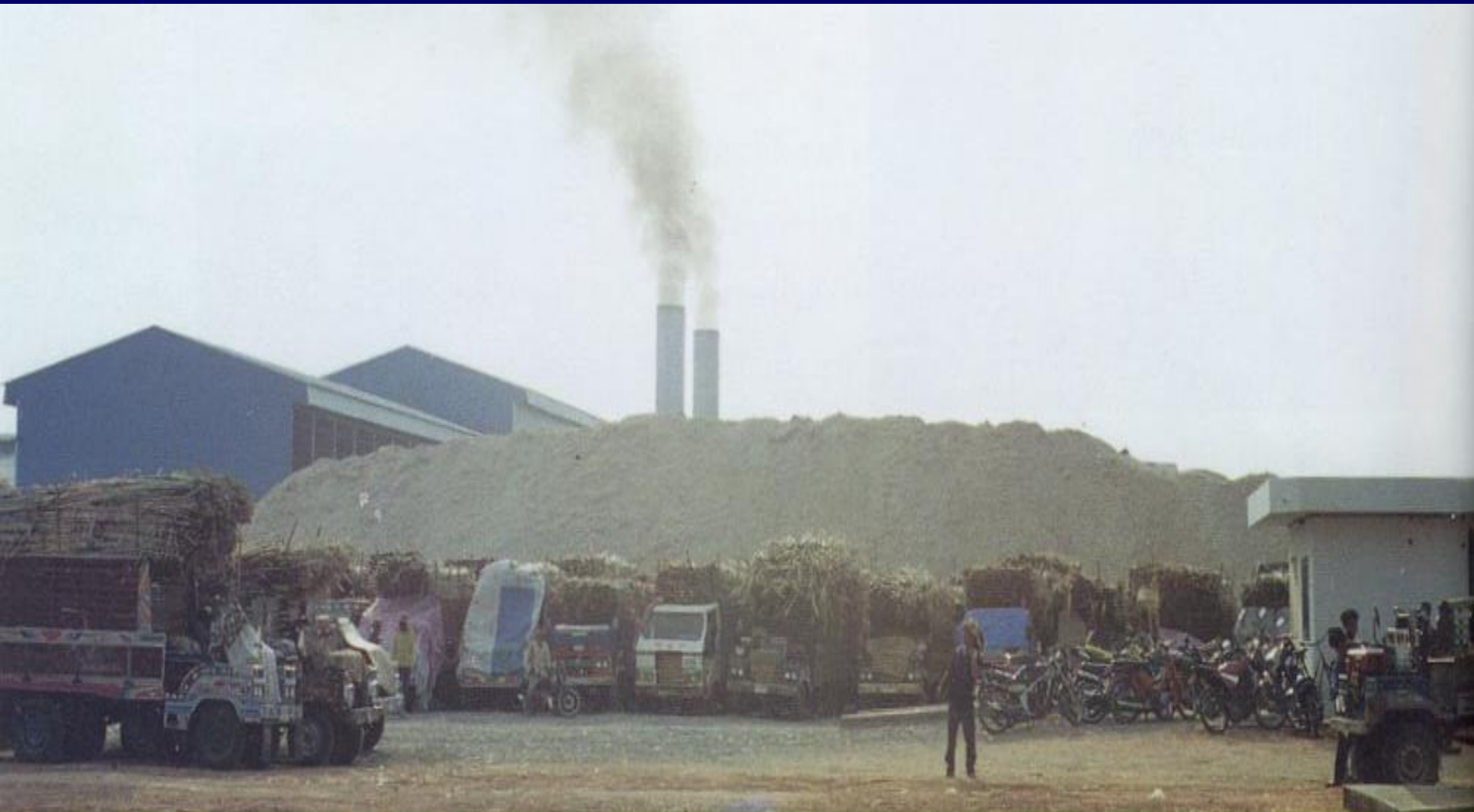
โรงไฟฟ้าที่ใช้กากอ้อยเป็นเชื้อเพลิง
