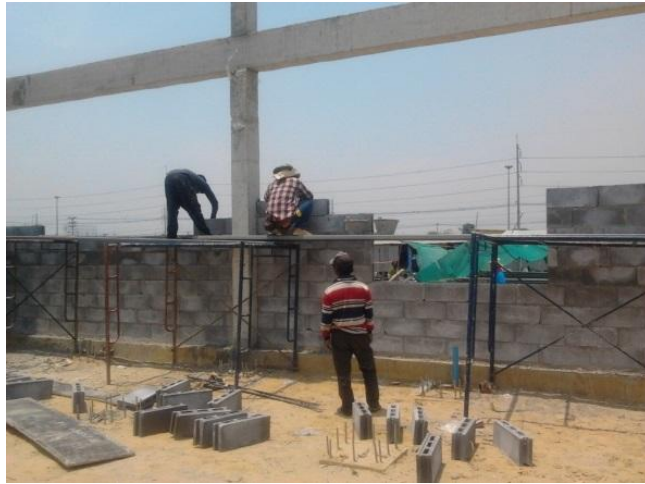
ภาพที่ 4 แสดงตัวอย่างการประยุกต์ใช้คอนกรีตบล็อกที่ได้พัฒนาขึ้น
