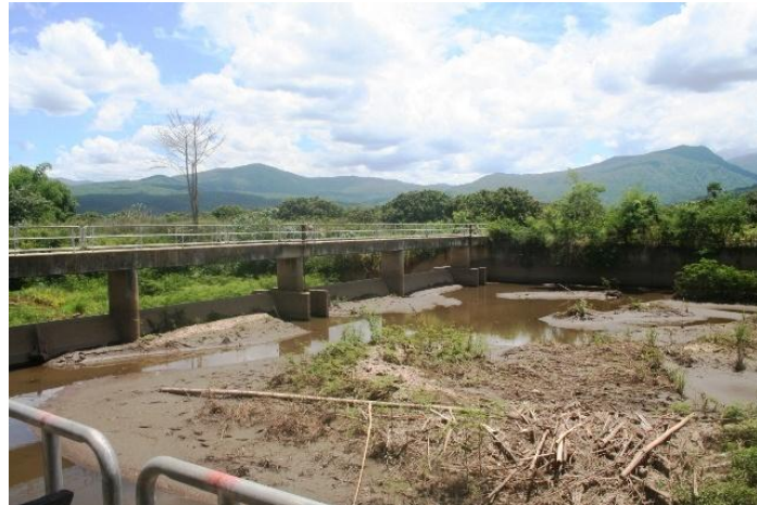
ภาพที่ 5 แสดงระดับน้ำและปริมาณทรายเหนือฝายในฤดูแล้งของฝายเหมืองหลวง อ.จอมทอง จ.เชียงใหม่
